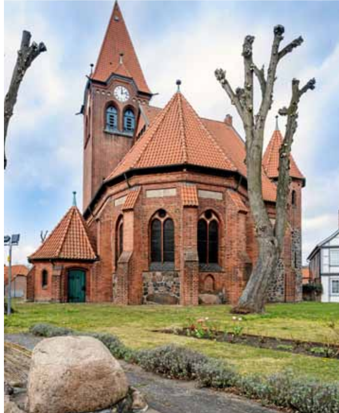
Die St. Johanniskirche in Dahlenburg gehört mit zum evangelisch-lutherischen Kirchenkreis Lüneburg. Der möchte in all seinen Gebäuden gucken, wo künftig Kohlendioxid eingespart werden kann, etwa durch neue Heizungen.
